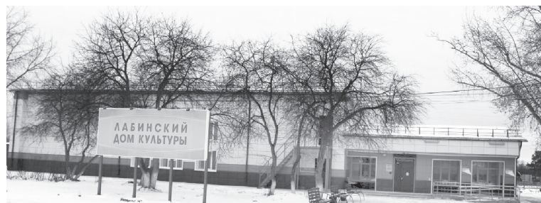
Капитальный ремонт Лабинского СДК – одно из значимых событий 2020 года
