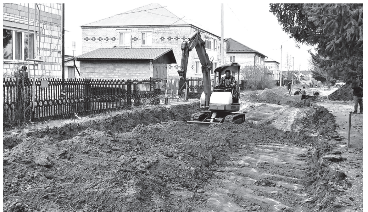
• Благоустройство территории возле домов №№ 94 — 106 на улице Революционной в городе идёт полным ходом. Скоро это место совершенно преобразится.
