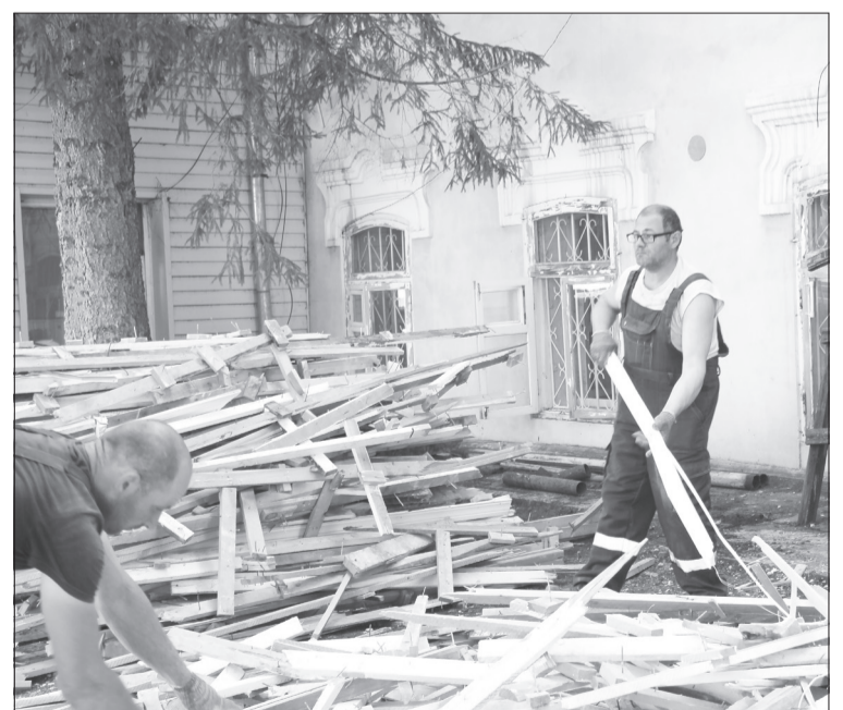
Сейчас рабочие подрядной организации полностью демонтируют и выносят все внутренние элементы здания
