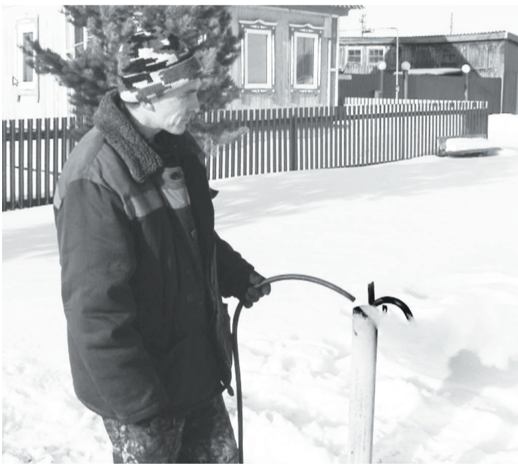
Ремонтник отогревает нажимной клапан водоразборной колонки паром.
