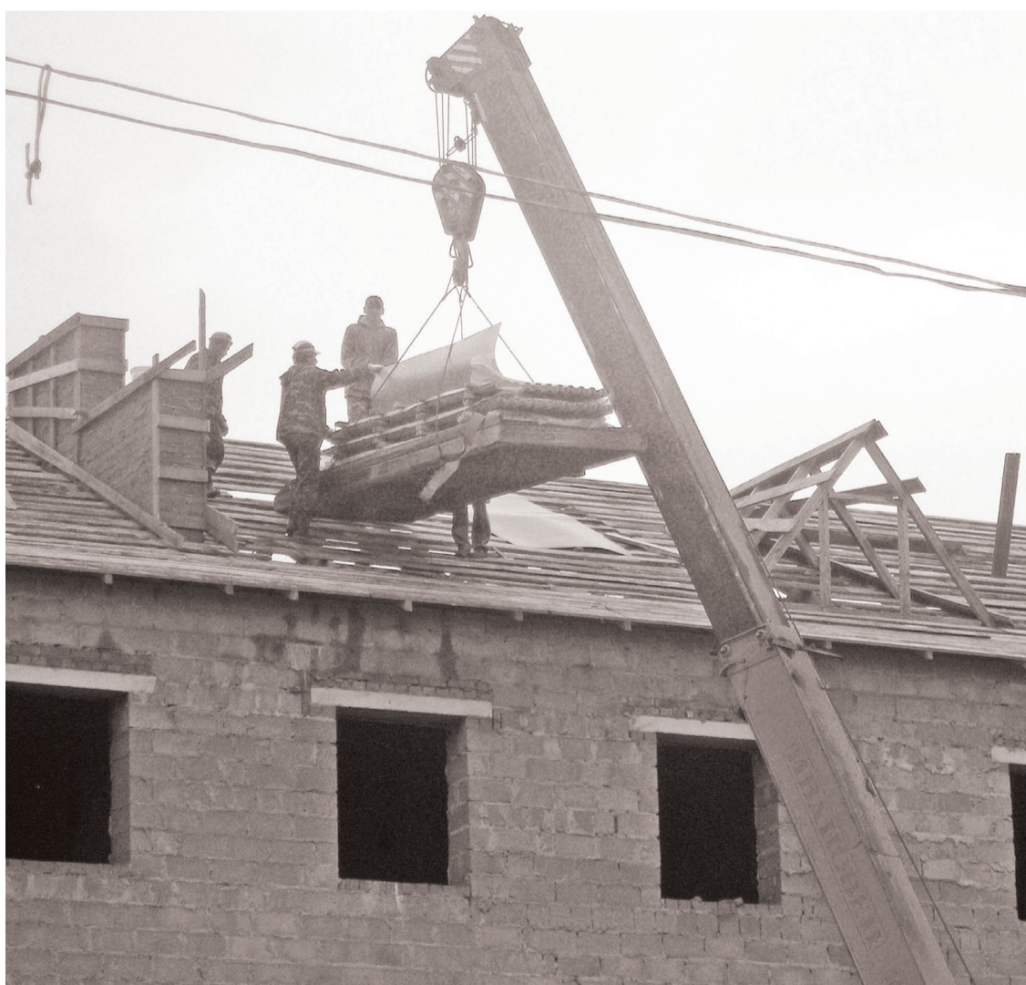
Остов здания на 45 квартир вырос как на дрожжах, вот и под крышу его подводить время пришло.
