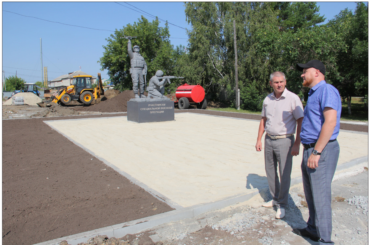
• Игорь Власов и Иван Пятилетов осматривают площадку, на которой ведутся строительные работы.
