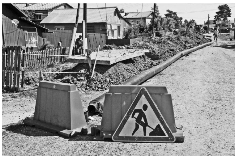
➤ Идут работы по укладке труб // Фото автора
