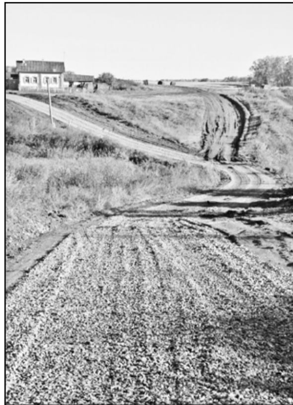
Но с этой осени проблемы уже не существует: на злосчастном перешейке проложено твёрдое покрытие
