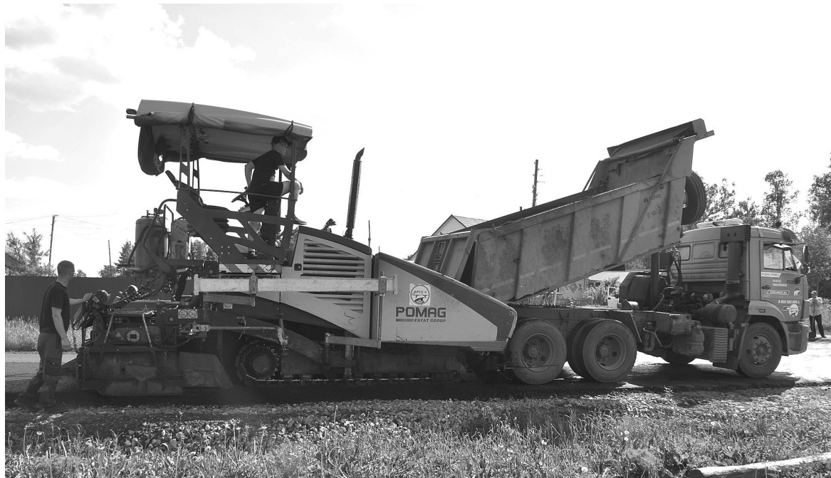
В сезон проходил ремонт дорог муниципального и регионального значений
