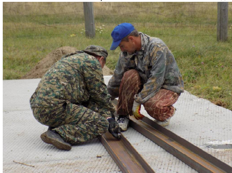
► Александр Куликов и Сергей Дерезлазов устанавливают фундамент для станции второго подъёма воды // Фото автора.
