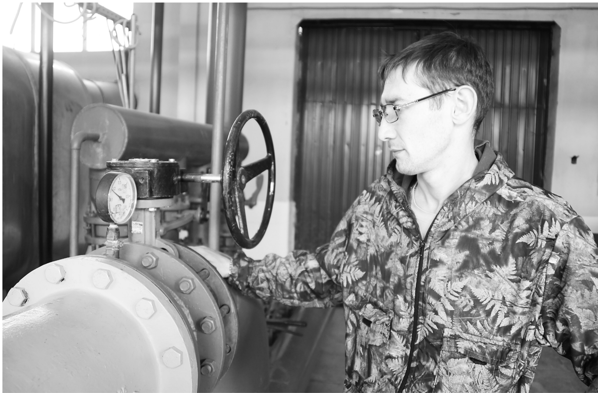
Оператор-слесарь газовой котельной ООО «Тавда-Уют» Василь Юнусов работает с фильтром грубой очистки воды.
