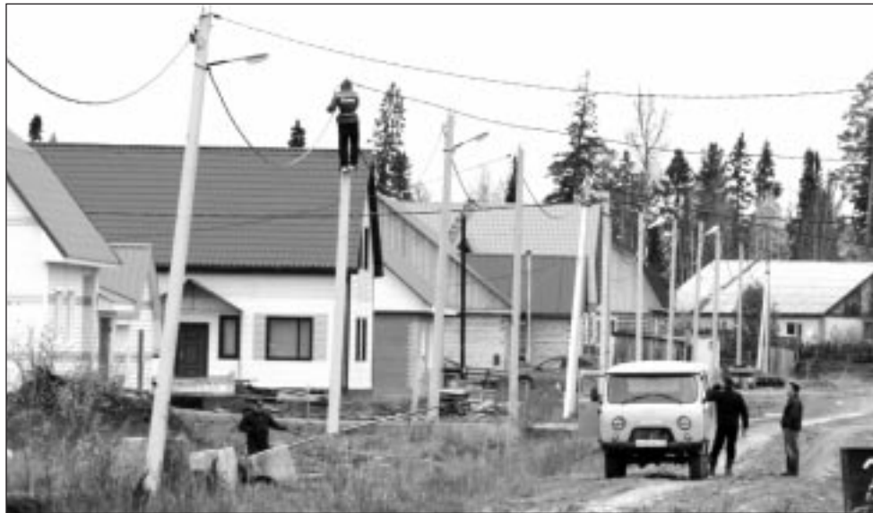
Подключение нового дома к линии электропередачи в микрорайоне Белый Яр.
