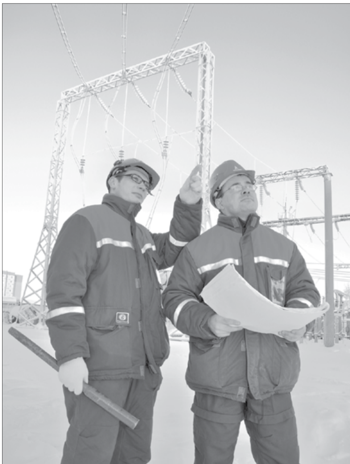
Электромонтёр Максим Исаков и инженер Дамир Тушаков проводят осмотр оборудования перед запуском в работу
