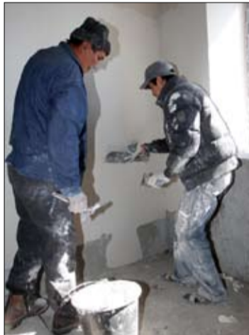
Шпаклёвка стен
