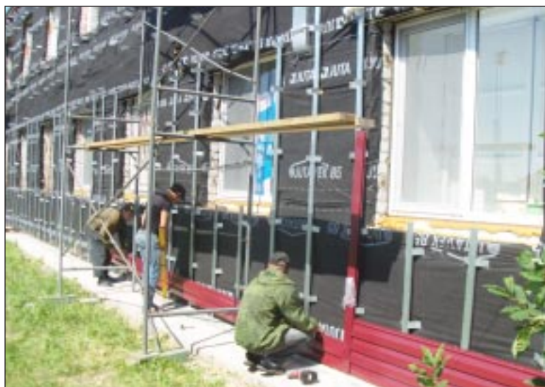
Здание районной поликлиники готовится к отделке металлосайдингом.
