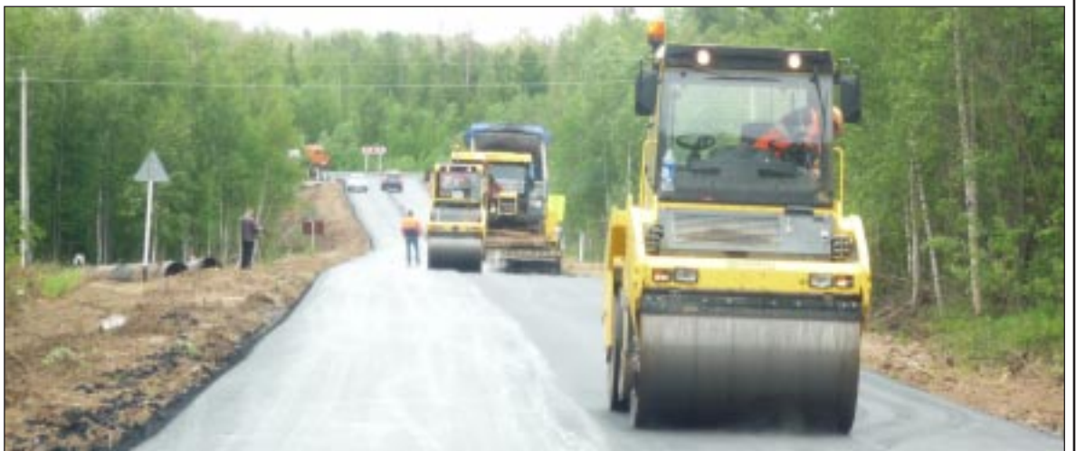
Укладка верхнего слоя асфальтобетонного покрытия.
