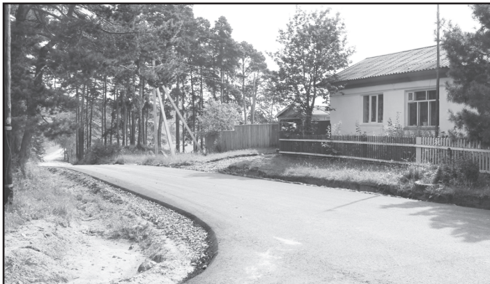
Участок дороги на улице Строителей
