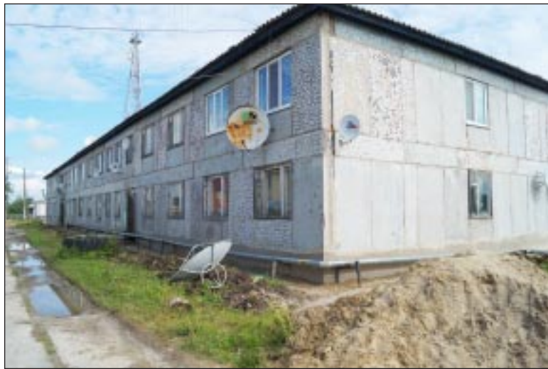
Дом готовится к утеплению стен, замене крыши, реконструкции инженерных сетей, ремонту полов и дверей.
