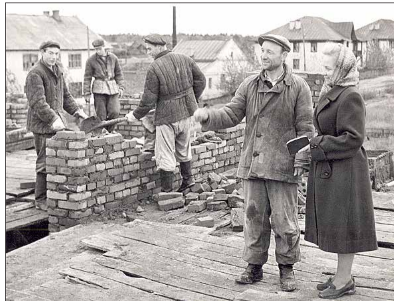
Шестидесятые годы. Ражевский стройучасток
