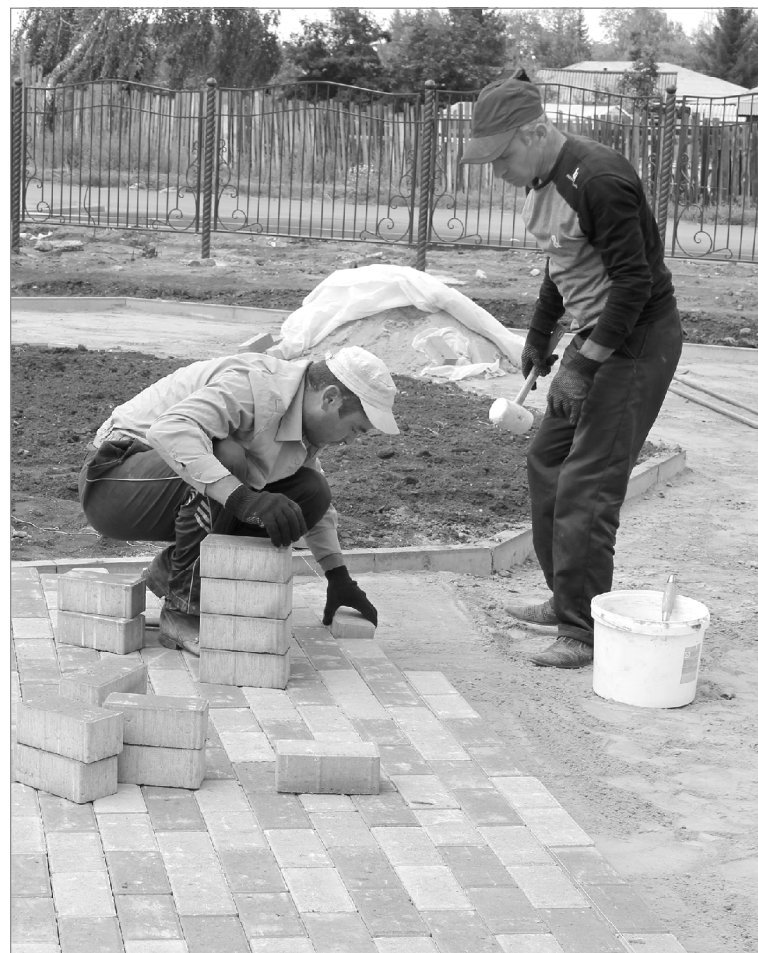
Идет укладка плитки во дворе школы № 4
