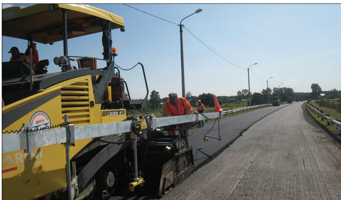
• За асфальтоукладчиком следуют четыре катка.
