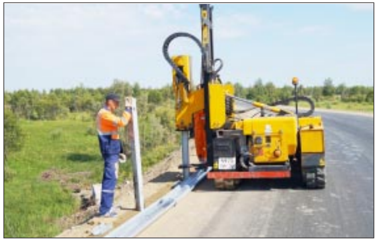
Установка защитных барьеров вдоль дороги на с. Осинник.
