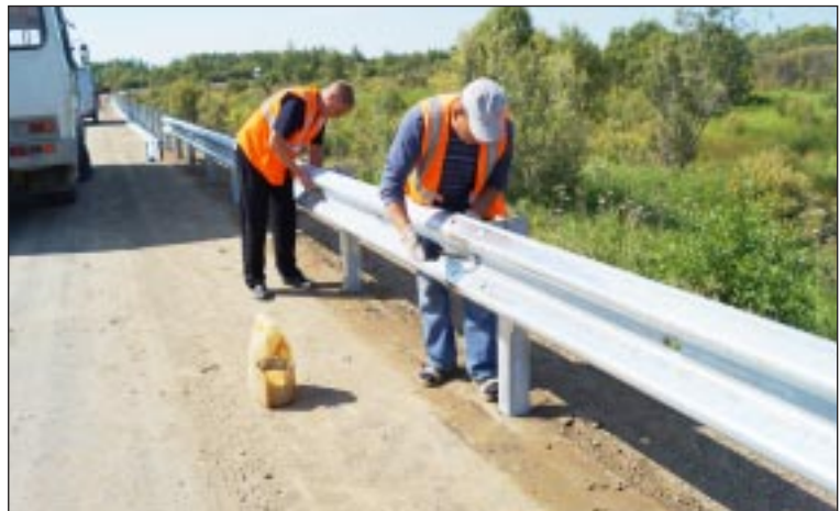
Установка защитных барьеров вдоль дороги на с. Осинник.
