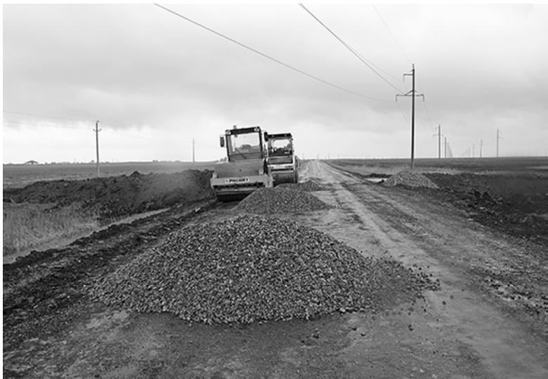
* Ремонт дороги возле д.Станичное
