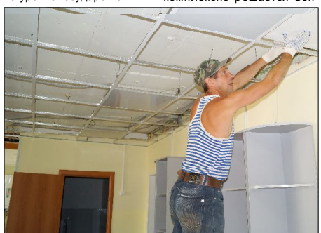
Монтаж подвесных потолков.
