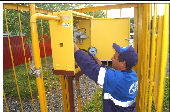
Проверка компрессии в газовом шкафу.
