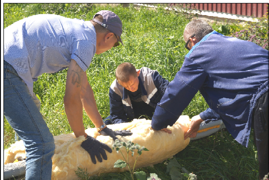
Утепление теплотрасс вспененным полиизтиленом.
