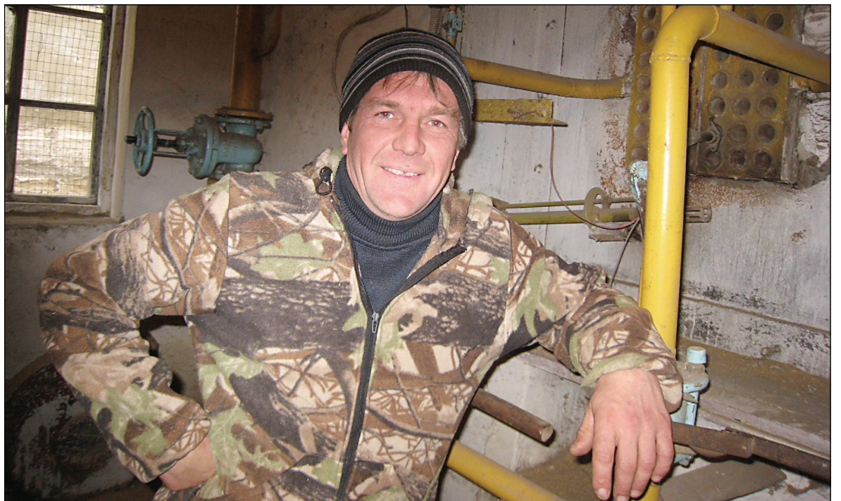
• Даже у пульта управления сушильным оборудованием, где работу всех механизмов отслеживает мастер Виталий Криштафук, ощущается высокая температура за стеной, где её задают два огромных газовых факела.
