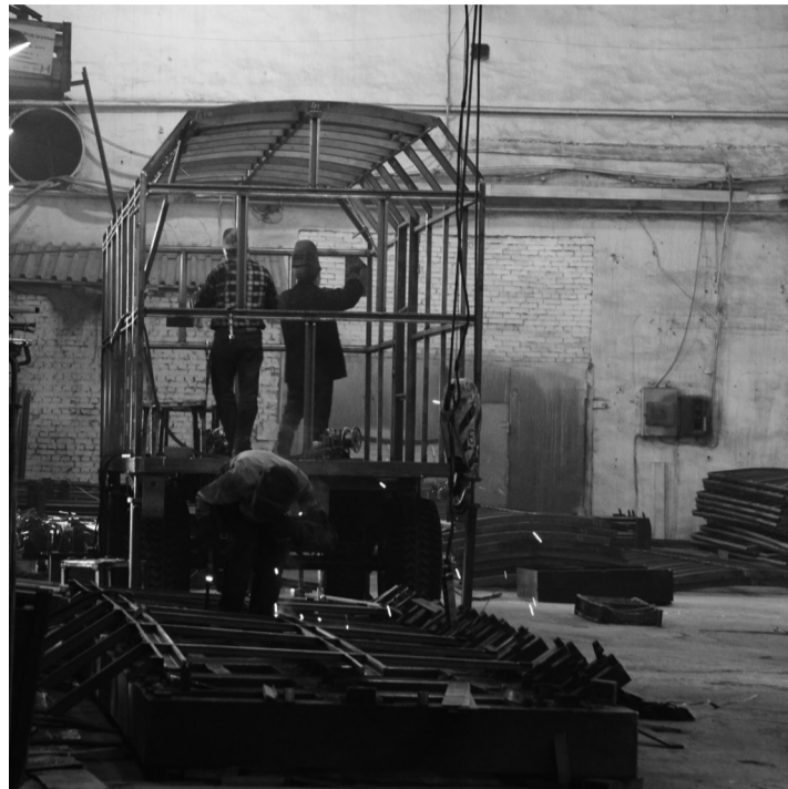
• В четвёртом цехе машзавода готов очередной каркас мобильного здания.
