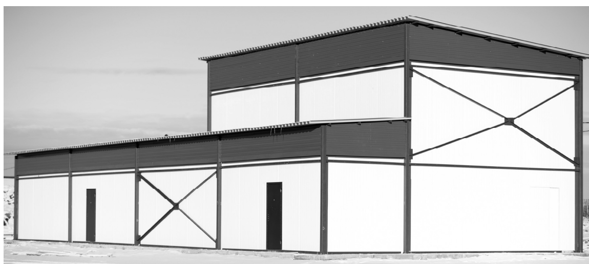
Будущий цех по забою скота и переработке мяса
