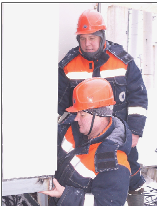
В.Н. Черкашин и А.В. Лучан выполняют монтаж выключателя.
