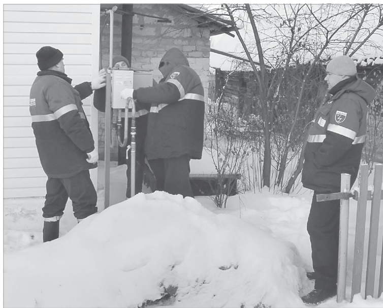
Идёт установка газового оборудования
